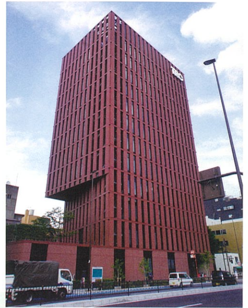
図書館流通センター 設計/鹿島建設 施工/鹿島建設
