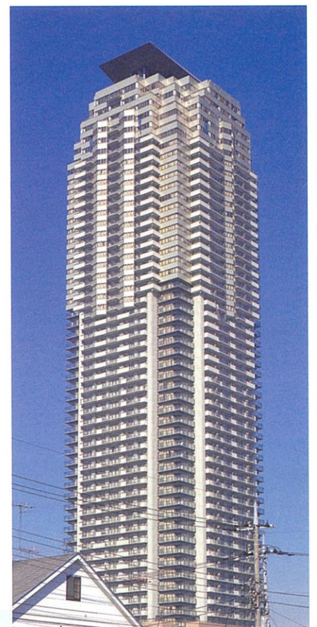
ライオンズプラザ川口 設計/竹中工務店 施工/竹中工務店 他JV
