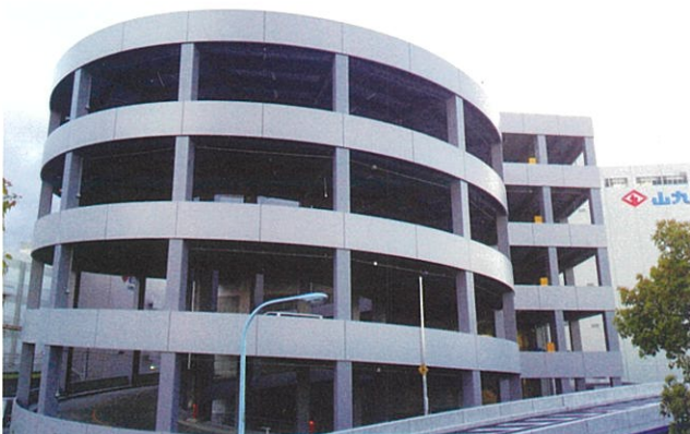
山九平和島ロジスティクスセンター 設計/鹿島建設 施工/鹿島建設
