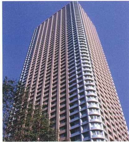
大川端リバーシティ北ブロックM棟
