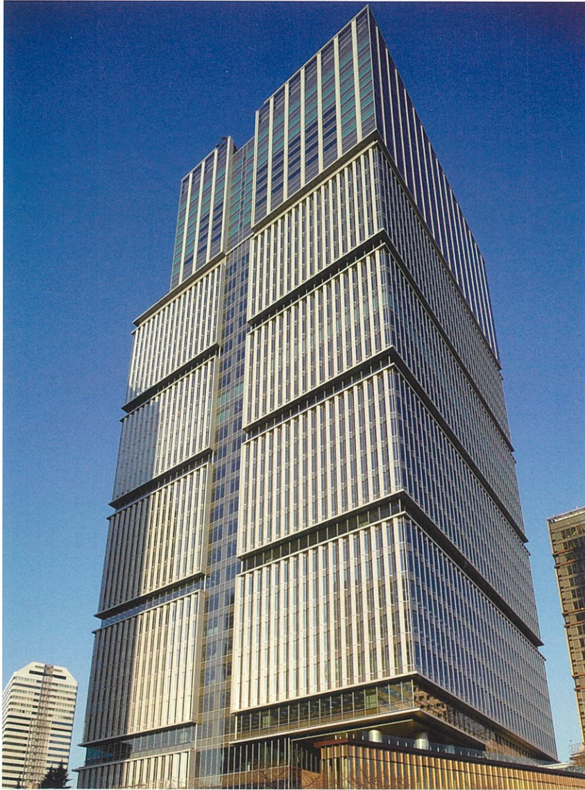
紀尾井町計画オフィス・ホテル棟(東京ガーデンテラス紀尾井町) 設計/日建設計 施工/鹿島建設 他JV
